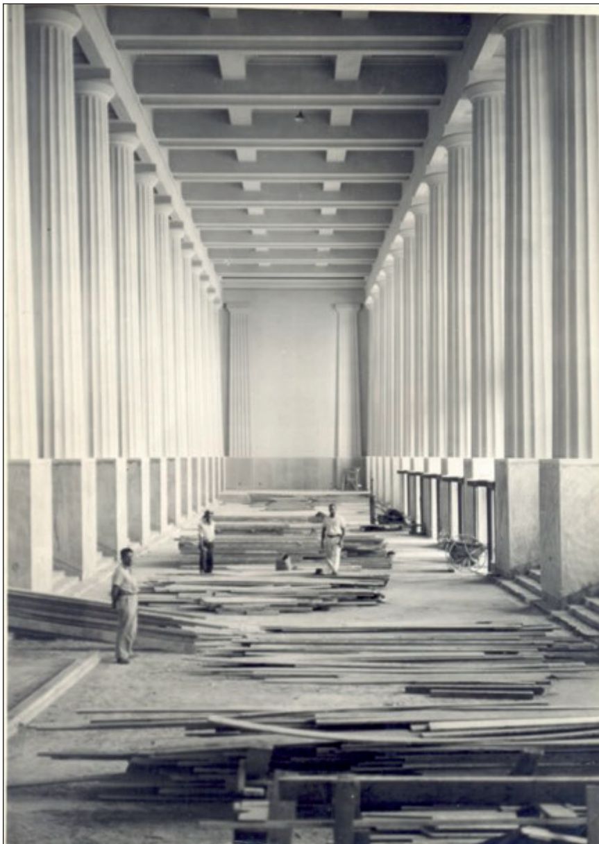
Pasos Perdidos en construcción (18)
